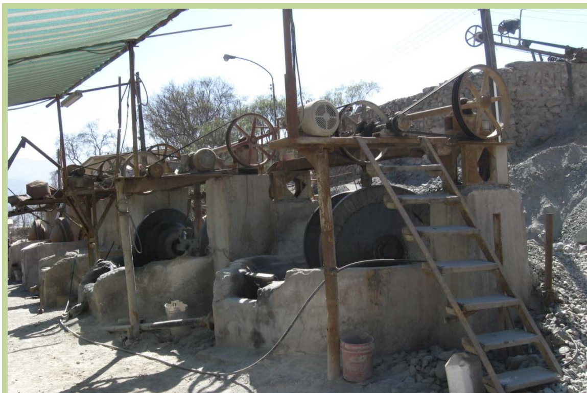
Figura 10. Trapiche operativo en planta Castellón. Aquí se realiza la molienda del mineral, donde se agregan reactivos de flotación al proceso.
